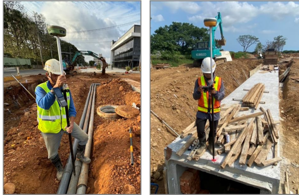
圖 10 管頂高直接量測
