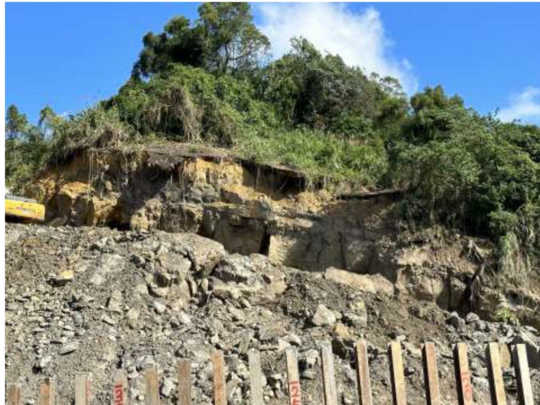
圖 21 地表岩屑隨時掉落之裸露危險岩面
