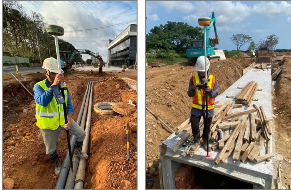
圖 10 管頂高直接量測
